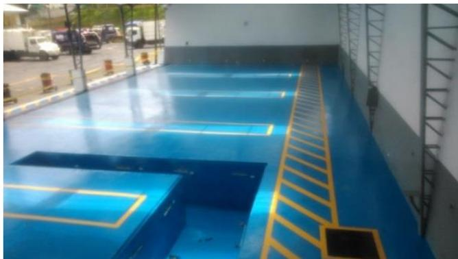
**Fig. 39 Recubrimiento epóxico del galpón 1 del taller**
