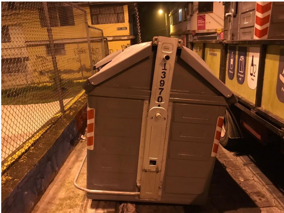
Foto 3: Instalación de contenedor Ruta Comité del Pueblo Fuente: Subdirección de Diseño de la Operación y Gestión Ambiental
