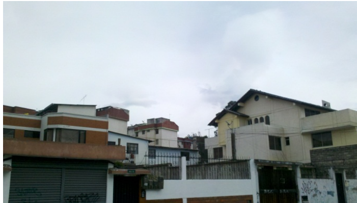
Fotografía N° 27. Tipo de Vivienda sector Agua Clara
