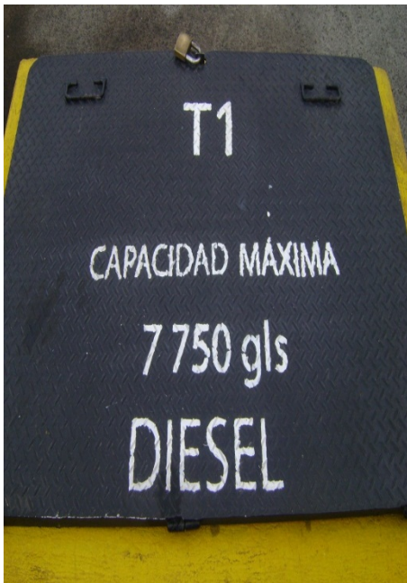
Fotografía N° 41. Tanque de almacenamiento de combustible (C.O. La Occidental)
