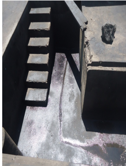
Fotografía N° 84. Canal de conducción hacia el desarenador en el área de lavado (C.O. La Forestal)
