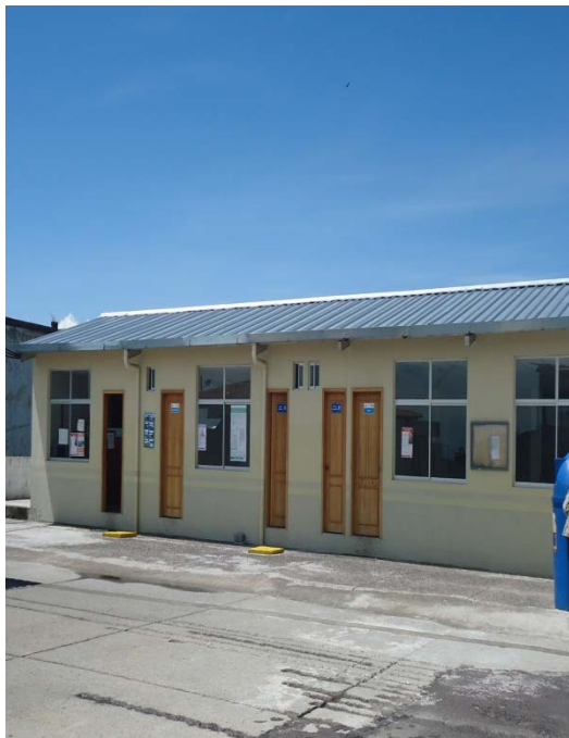
Fotografía N° 69. Edificación de servicios (C.O. La Forestal)
