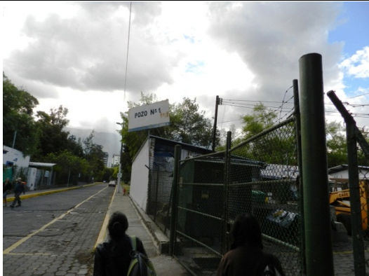
Fotografía N° 151. PDM 1.- Entrada principal
