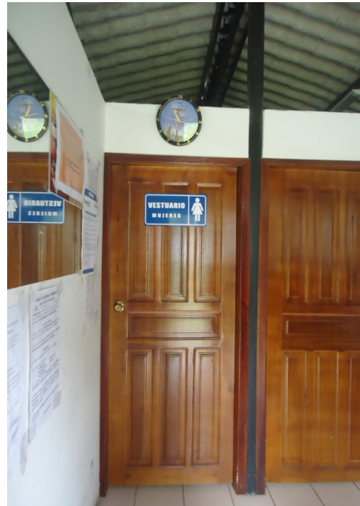
Fotografía N° 140. Vestidores / baños para mujeres (izquierda) y hombres (derecha)
