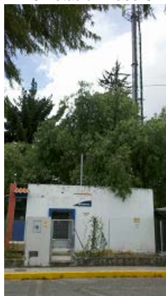
Foto N°. 3 Estación Base CNT EP
