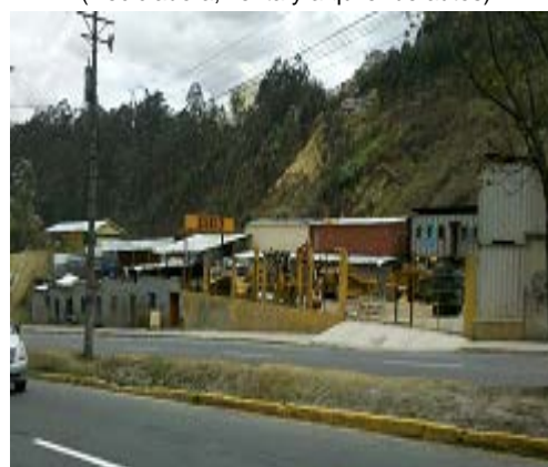
Foto N°. 4 Vista Oeste: Negocios junto al Cuartelillo (Recicladora, venta y alquiler de autos)
