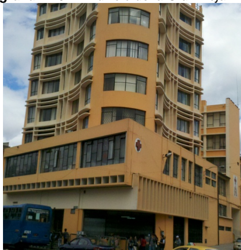
Fotografía N° 64. Edificio de la Cruz Roja Ecuatoriana
