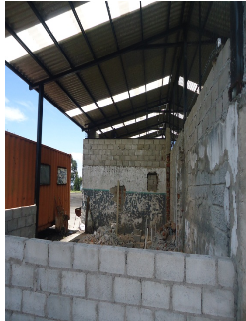
Fotografía N° 80. Bodega de repuestos (C.O. La Forestal)
