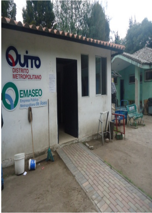
Fotografía N° 117. Exterior del cuartelillo La Carolina
