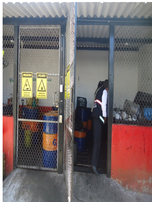
Fotografía N° 86. Almacenamiento de aceites nuevos (izquierda) y desechos peligrosos (derecha)
