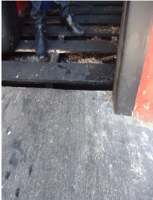
Fotografía N° 87. Canaleta de la bodega de filtros usados (C.O. La Forestal)
