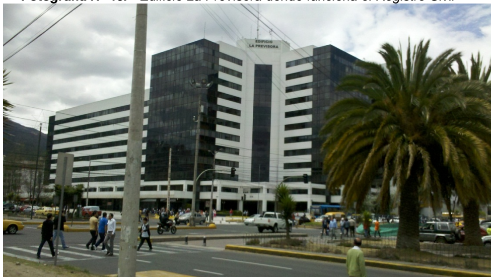
Fotografía N° 46. Edificio La Previsora donde funciona el Registro Civil
