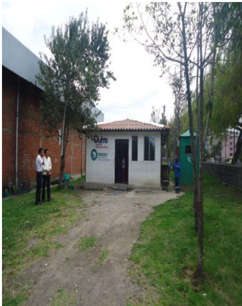
Fotografía N° 127. Exterior cuartelillo Mercado Mayorista (C. Mercado Mayorista)
