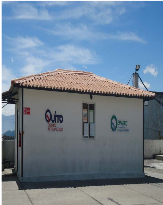
Fotografía N° 67. Edificación de supervisores (C.O. La Forestal)
