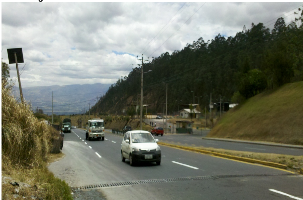
Fotografía N° 47. Vía de acceso a la entrada del Cuartelillo Zámbriza
