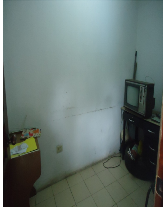
Fotografía N° 118. Oficina del supervisor (C. La Carolina)
