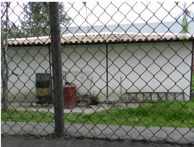
Fotografía N° 132. PDM 3.- Parte trasera del cuartelillo.
