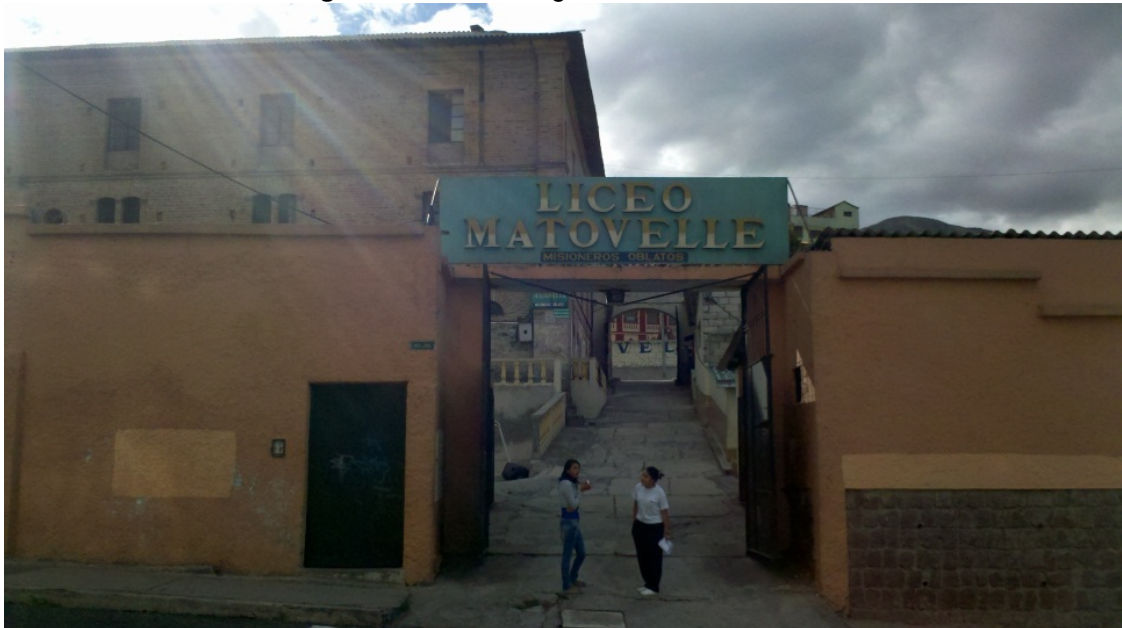
Fotografía N° 69. Colegio Liceo Matovelle
