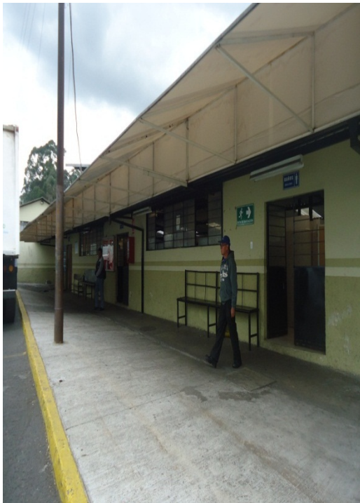
Fotografía N° 29. Vestidores (C.O. La Occidental)
