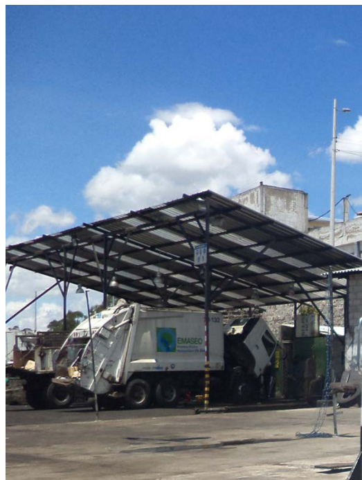
Fotografía N° 85. Taller mecánico (C.O. La Forestal)
