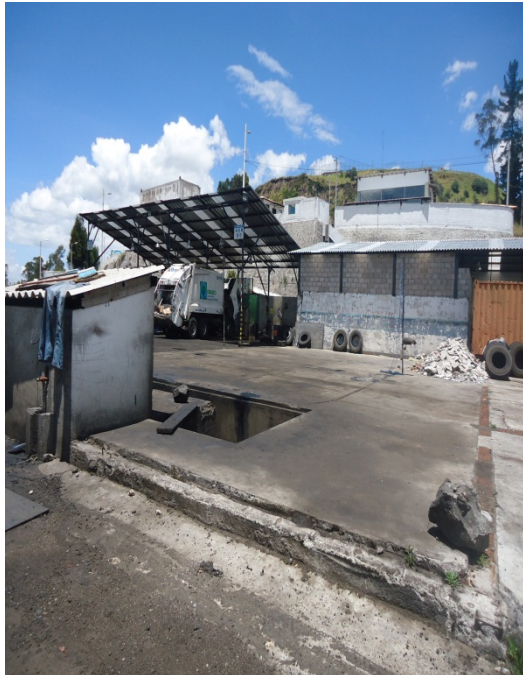
Fotografía N° 83. Área de lavado de vehículos (C.O. La Forestal)
