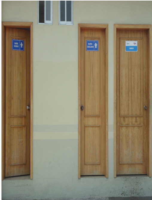
Fotografía N° 71. Baños junto al comedor (C.O. La Forestal)
