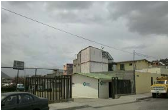
Foto N°. 1 Cuartelillo La Ofelia
