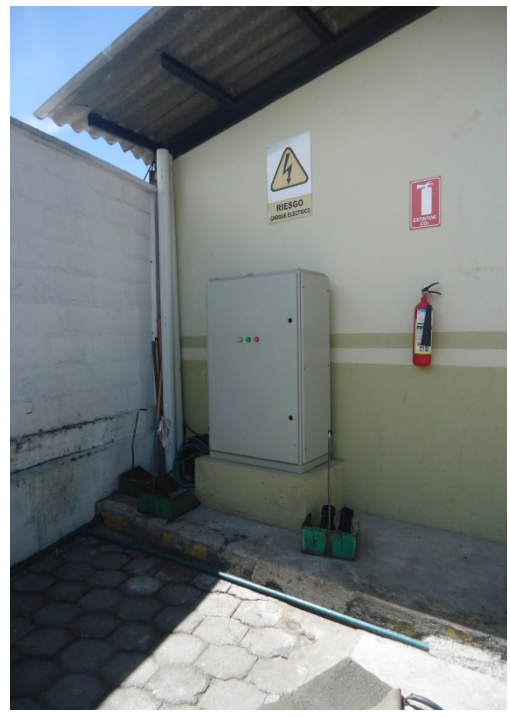
Fotografía N° 62. Transformador (C.O. La Forestal)
