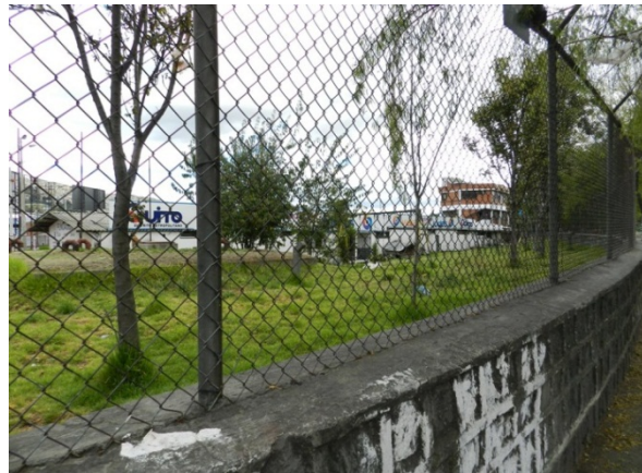
Foto N°. 4 Esquina final del cuartelillo
